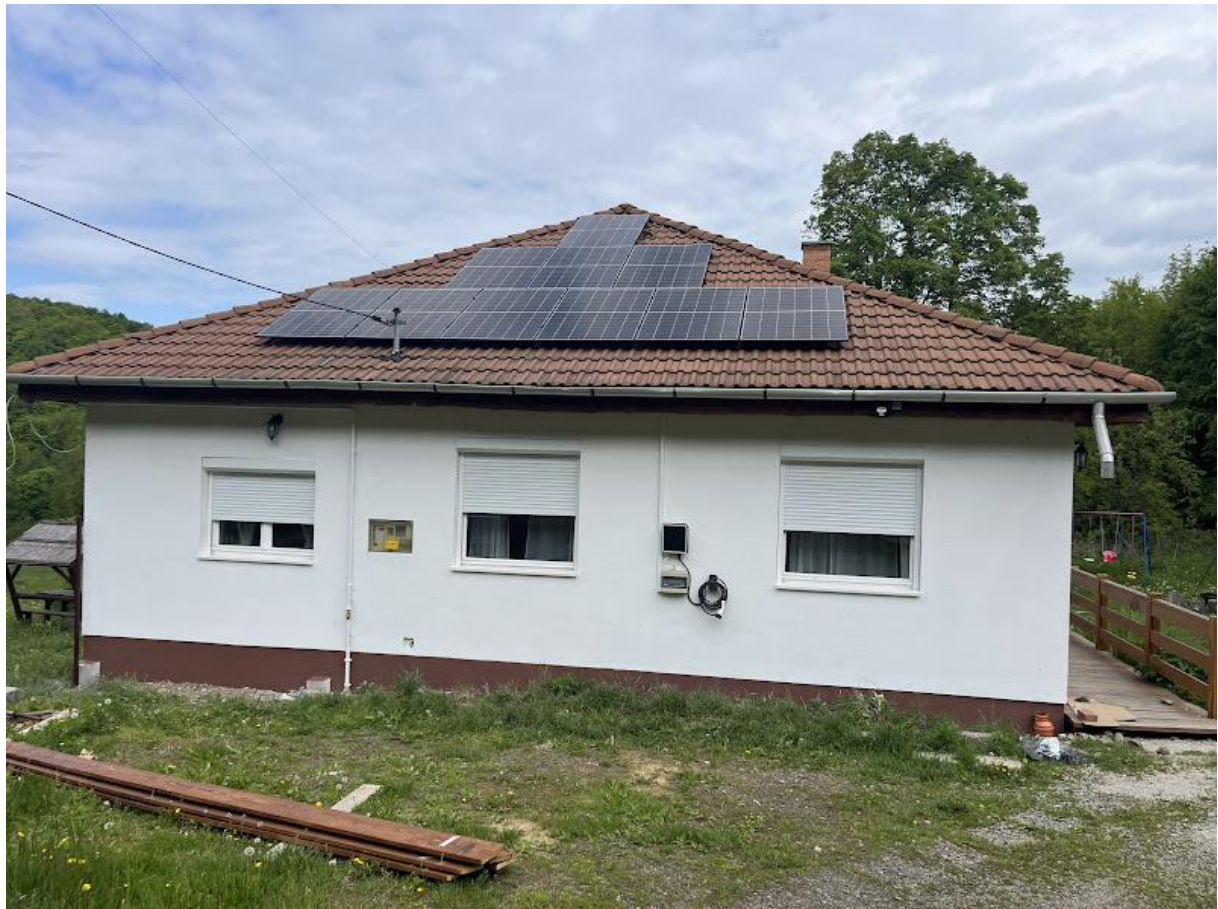
külső hőszigetelő burkolat az energiahatékonyság jegyében
